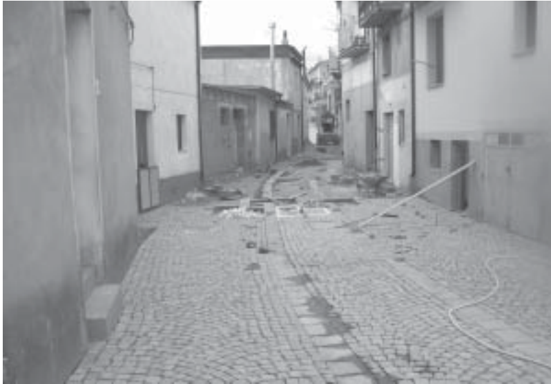
Pavimentazioni in Via Diaz - Foto giu/ri
